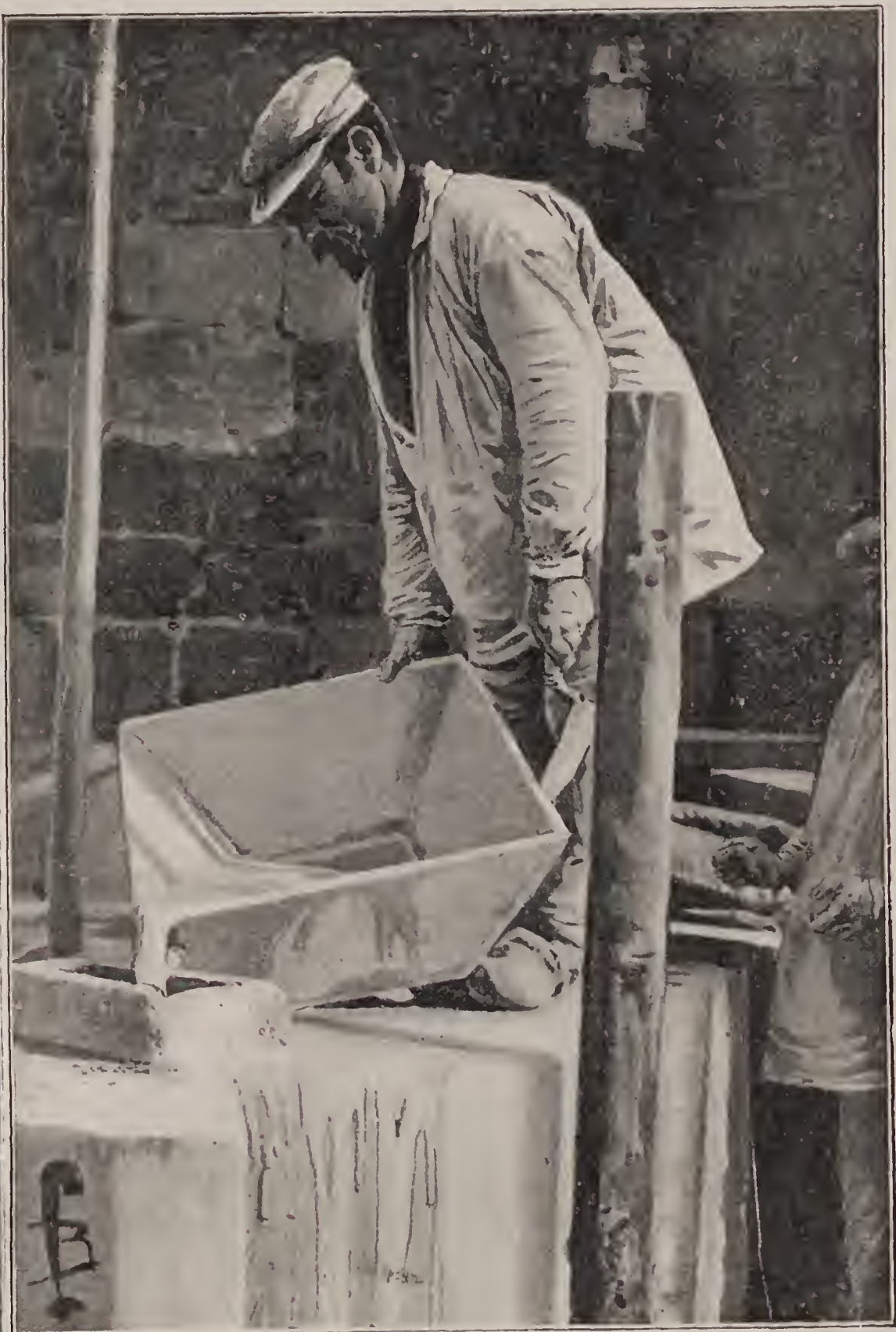
Fichage au plâtre fin de la pierre, mise en place.
